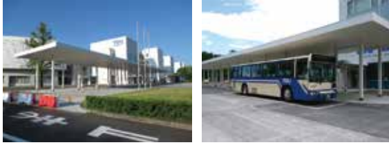
本館前広場のバス停屋根増設
