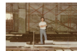
ビルマの水力発電所工事現場
