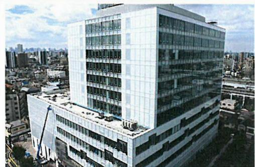
建物の外装工事はほぼ完了。建物内部で間仕切り等の内装工事や設備工事が進んでいます。10月3日には仮設電源を切り離し、変電所から送電開始。1号館の特別高圧受電設備で6kVに降圧後、地下共同溝経由で5号館へ送電。もちろん絶縁抵抗試験、耐圧試験、保護連動試験等は合格。(外観ほぼ完成。工事関係者皆さまに感謝)
