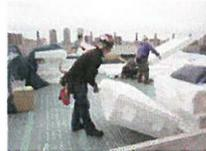
建設工事は予定通り進捗しています。10月13日には消防署による中間検査が終了し、無事に合格しました！低層部屋上のルーフガーデン整備工事も始まり、植栽の盛土には発泡スチロールを使用した「EPS工法」を採用。建物の荷重負担を軽減させています。(TDUは北千住東口のランドマーク)
