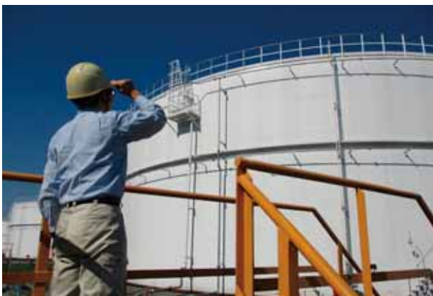
航空燃料を貯蓄するタンク設備
