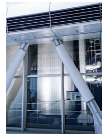
建物内部からも蓄熱槽を見ることができます
