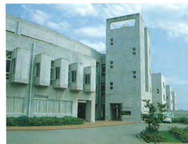
理工学部図書館棟(キャレル:閲覧個室)から実験棟を望む 昭52.4.27.
