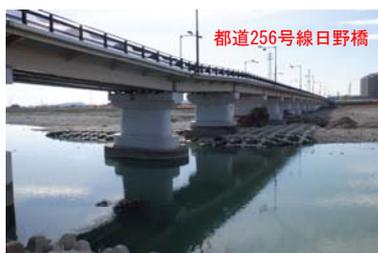
**特徴：**①山中の急流により護岸の侵食、橋脚の洗堀による被害が発生した。②中流にあたる日野橋でも洗堀が発生した。③鉄道橋でも洗堀被害が発生しているとのことである。
