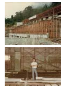
ビルマの水力発電所工事現場
