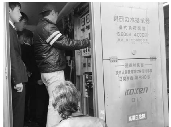
興研の水抵抗器と自揚型移動式高圧発電装置 1,000kW×3台=3,000kWを用いた負荷試験の様子
