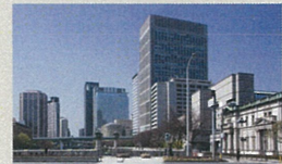
▲ 弊社がビル1棟すべての電線設備・無線設備を企画・設置しているビルの例
